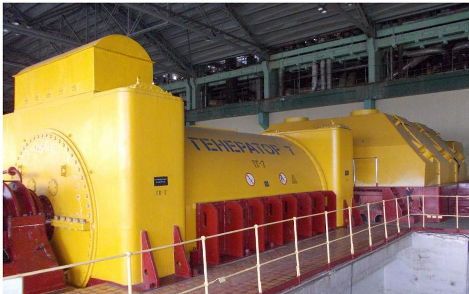
Турбогенератор мощностью 320 МВт
