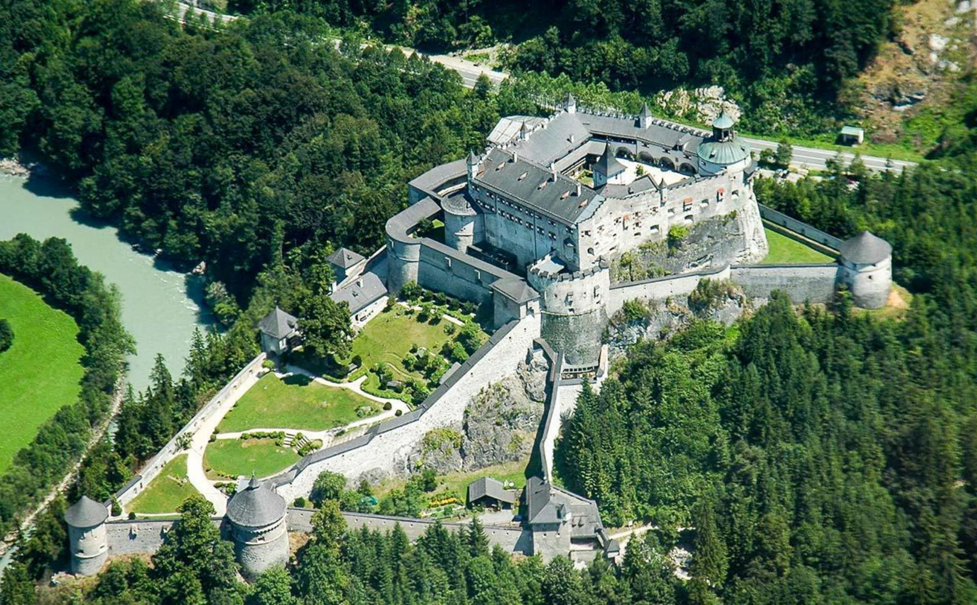
Замок Хохенверфен. Австрия, XI в. Фото
