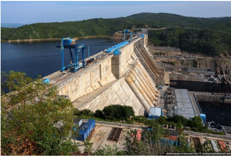
Бурейская ГЭС одна из крупных на Дальнем Востоке
