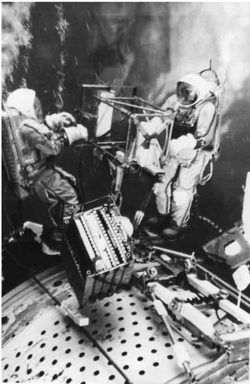
Рис. Фото во время тренировки в бассейне гидроневесомости по отработке операций сборки фермы к предстоящему эксперименту «Софора»
