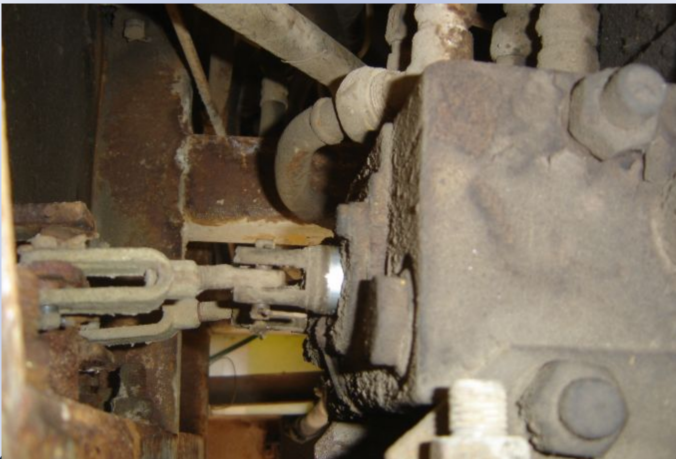
Гидрораспределитель и тяги, идущие к рукояткам управления ковшом и стрелой рабочего оборудования
