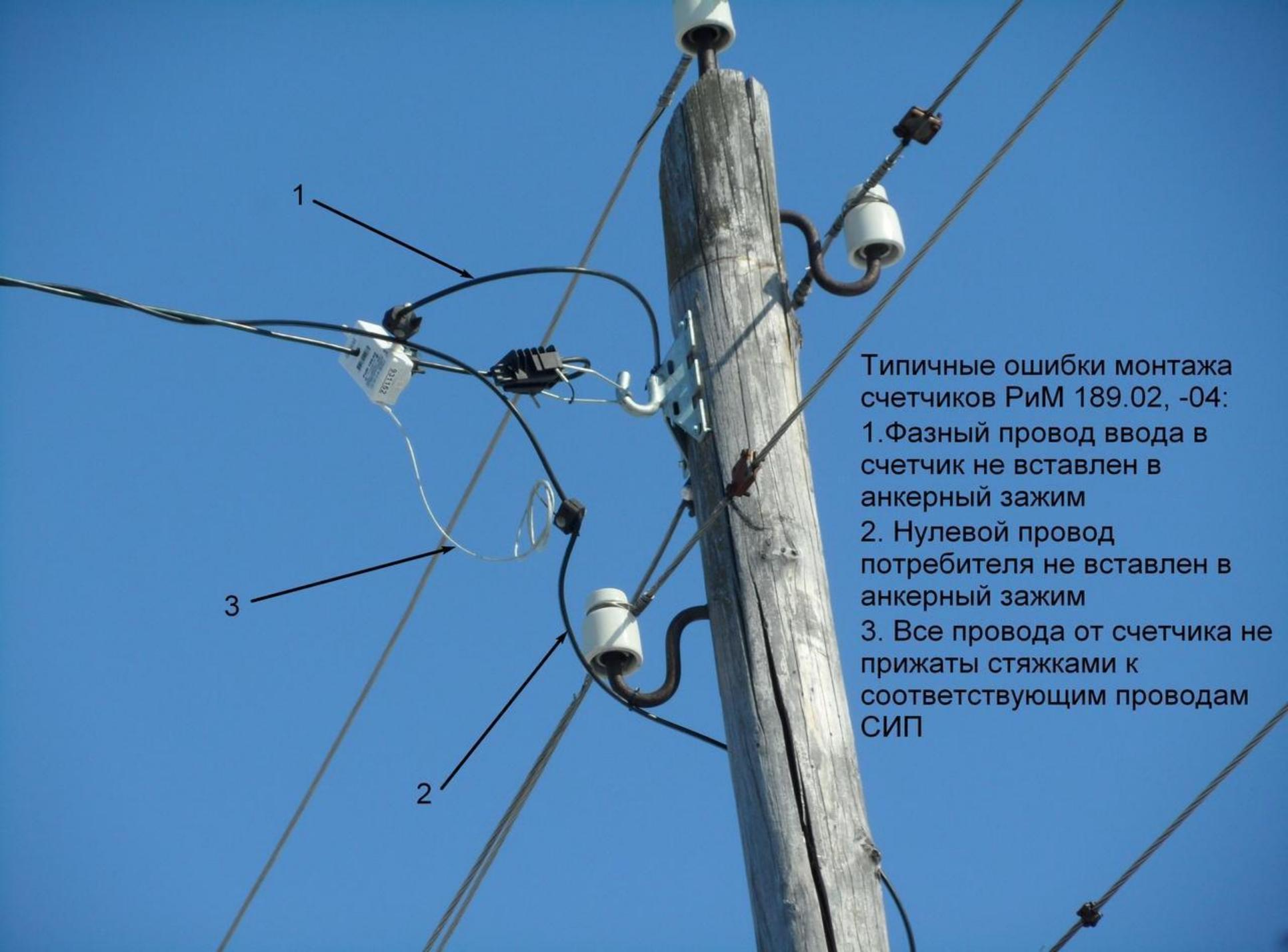
Типичные ошибки монтажа счетчиков РИМ 189.02, -04:
