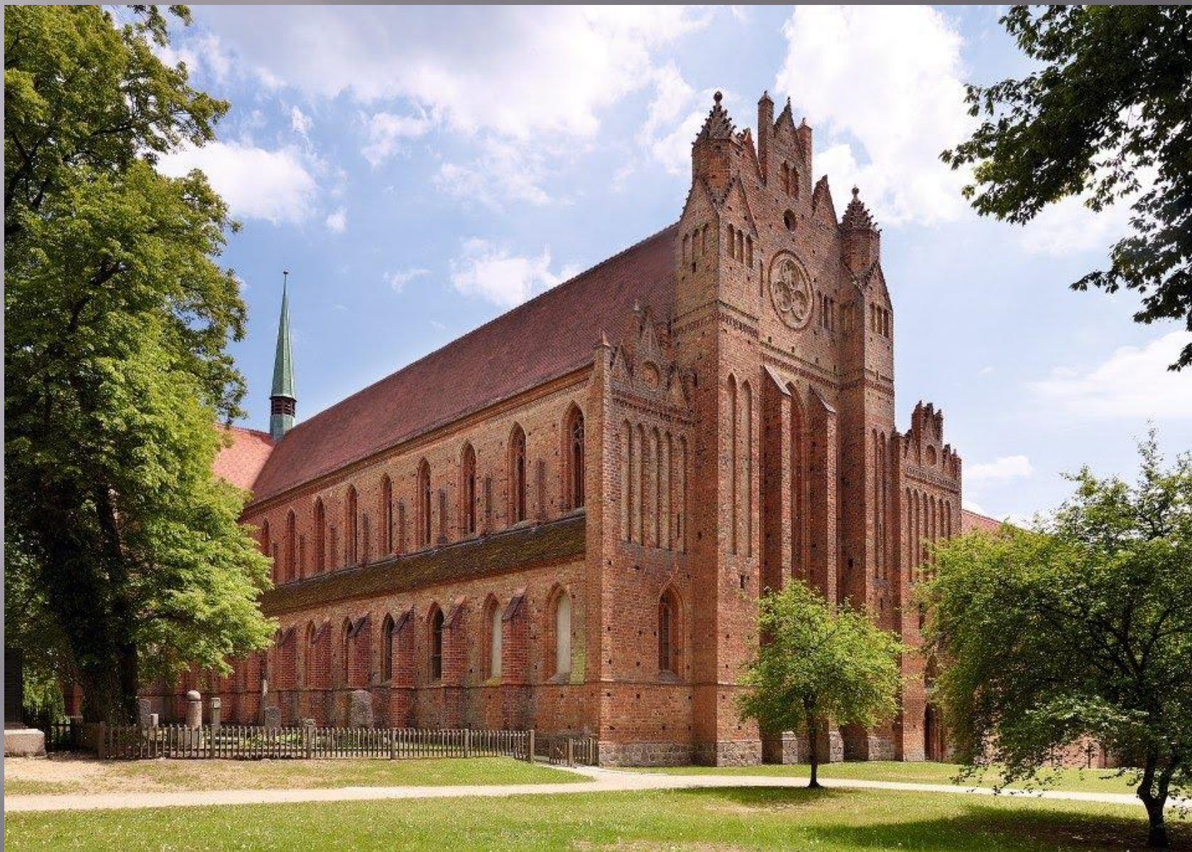
церковь в Хорине (1258 г.)
