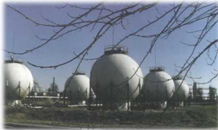
Хранилище сжиженных газов
