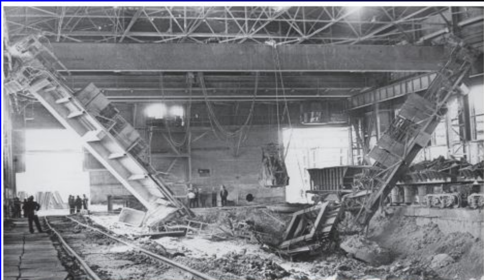
Рис. 6. Место аварии мостового магнитно-грейферного крана грузоподъемностью 15 т
