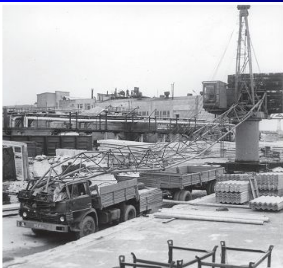
Рис. 23. Место аварии башенного крана БКСМ-511
