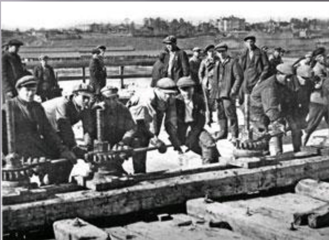
Строительство железобетонного моста им. В.И. Ленина (1932-1936)
