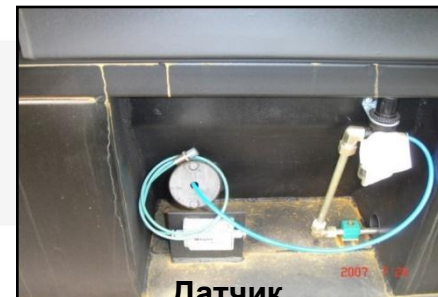
Датчик температуры инертных
