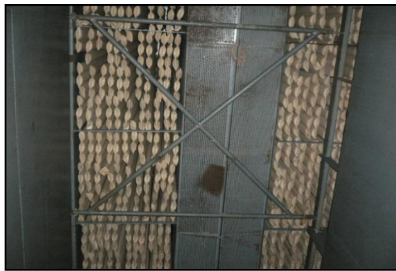
Фильтровальные мешки установлены в алюминиевых клетях , что предотвращает преждевременную коррозию и порчу фильтра
