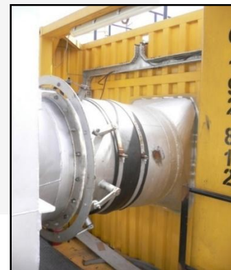
Вытяжной вентилятор подключенный к модулю фильтровальных мешков
