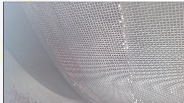
Состояние экранных сит после процесса просеивания & сушки
