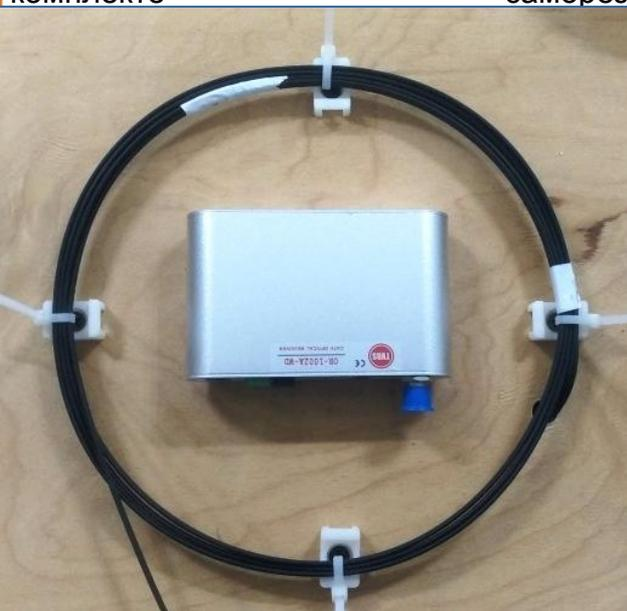
5) Зафиксировать кольцо ОВК стяжками на площадках. ОВК не должна сильно перегибаться в местах захода в дом и в ОНТ. Подключить оптику в терминал до щелчка
