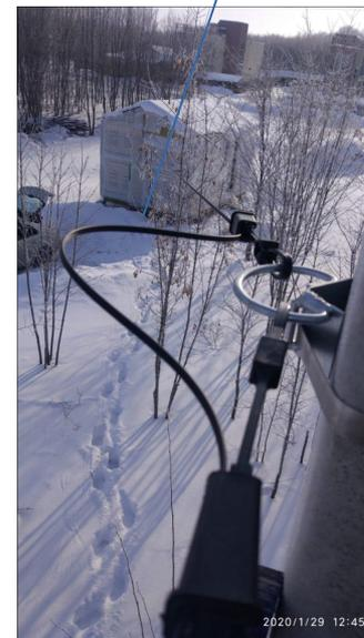
При подключение абонента патч-кордами, запас оптики оставляем на ШОРе/чердаке клиента (где его не будет видно). На фасаде дома запас оптики оставлять категорически запрещено. Минимальный запас кабеля, который необходимо оставить со стороны ШОРа, это опуск до земли + 2 метра.
