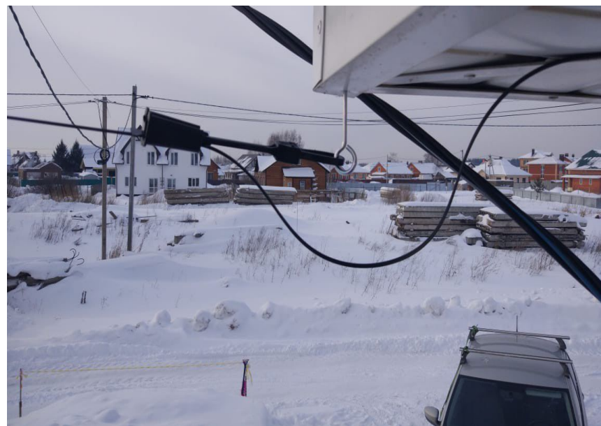
Шлейф при переходе с анкерной точки на стену
