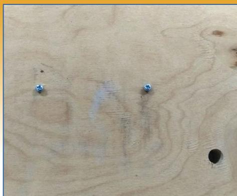
2) Располагаем приёмник так, чтобы входное отверстие ОВК было возле одного из нижних углов. Устанавливаем крепления (дюбель-гвозди либо саморезы)
