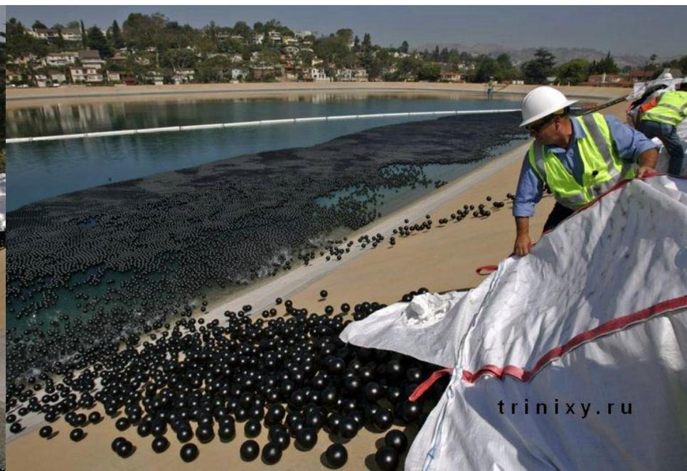
В Лос Анджелесе закрывают поверхность воды пластиковыми шарами, чтобы солнечные лучи не проникали в воду и не образовывались ядовитые химические соединения.
