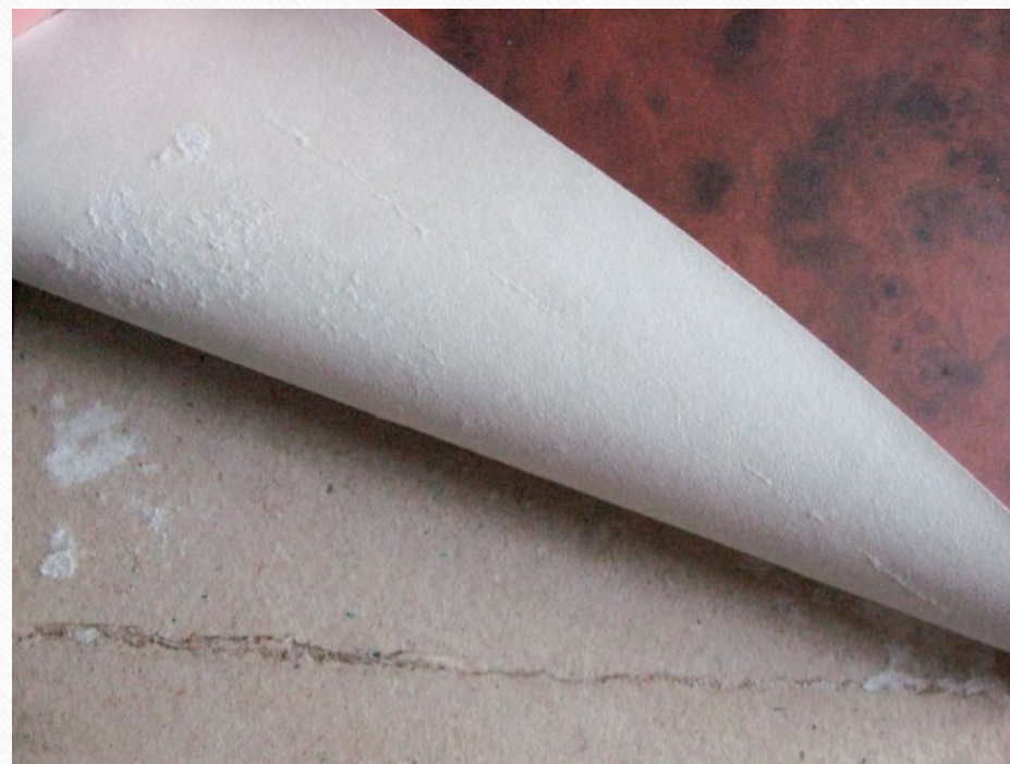
Трещина крышки
