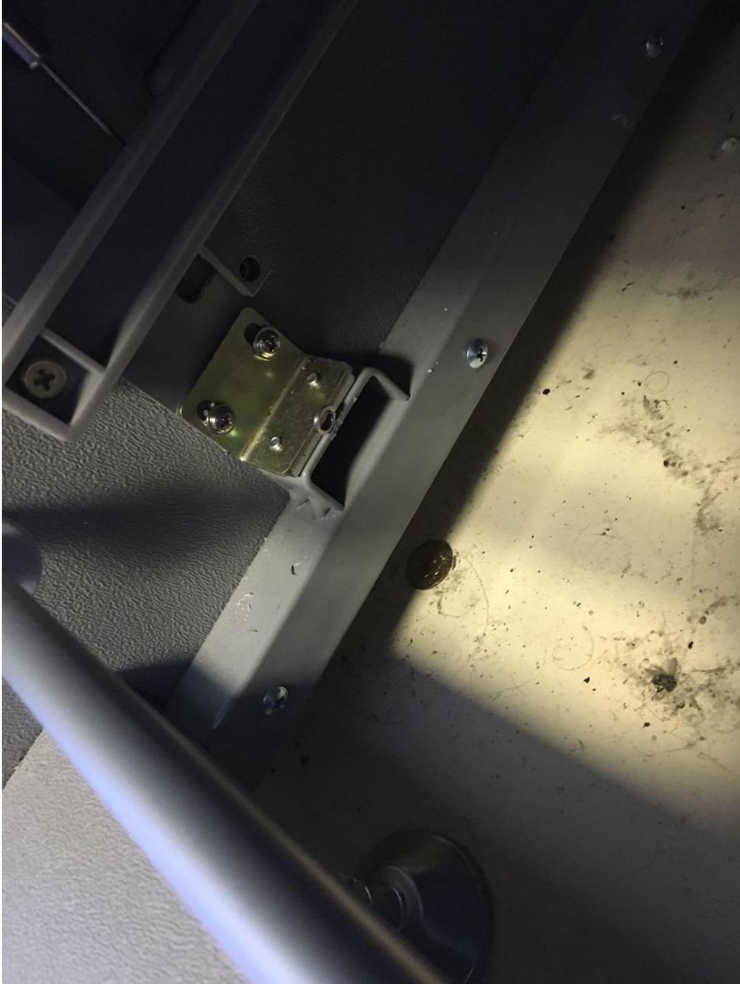
В низу шкафа находятся магниты по обеим сторонам. На них ничего не должно быть примагничено, это мешает полному открыванию шторок. Также они должны быть правильно настроены. Шторки в открытом состоянии, параллельно полу, магниты с обеих сторон плотно прилегают к основанию. Для настройки слегка развинчиваются винты шторки устанавливаются в горизонтальное положение, винты затягиваются.
