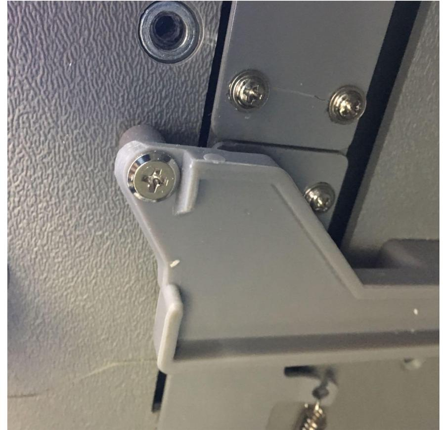
Соединение планки синхронизации шторок. Обязательно должно быть 4 винта, как на картинке, если другие, то шкаф был собран не верно. Обязательно в стык в стык, без нахлеста.
