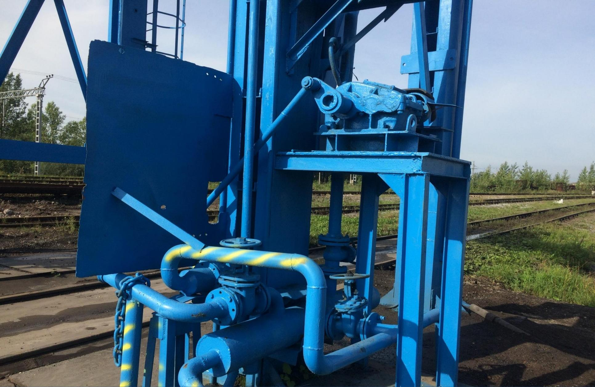
Рис. 4 - правый гидромонитор очистки вагонов.
