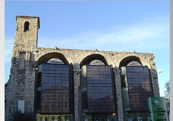
Реконструированное здание Бюро по туризму, Франция
