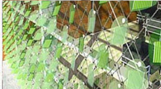
Фотоэлектрические элементы, имитирующие растения на фасаде Такой вариант энергоэффективной реконструкции был разработан для здания, Внешний облик которого должен был остаться неизменным.
