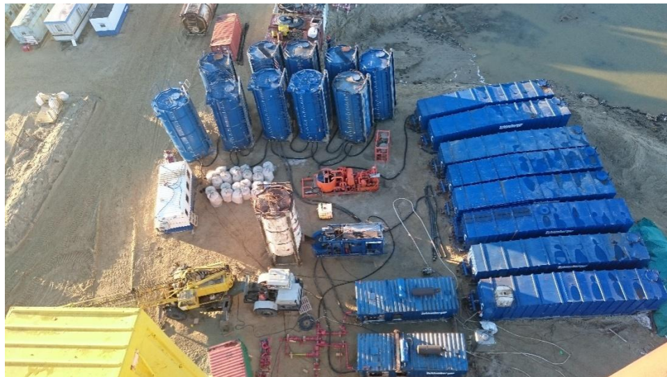
Расстановка оборудования для гравийной набивки
