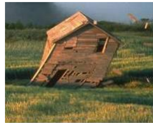
4. дом, разрушаемый ураганом
