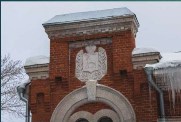
Здание пожарной части на улице Чернореченской
