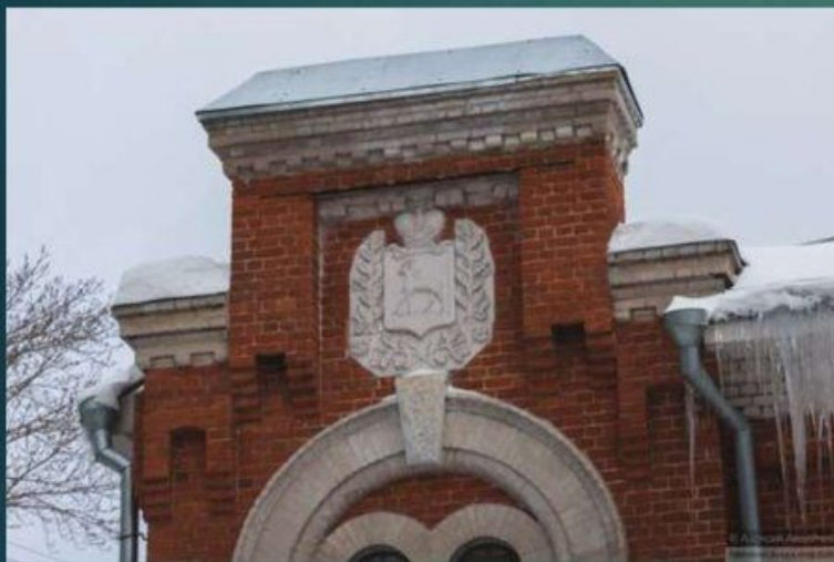
Здание пожарной части на улице Чернореченской
