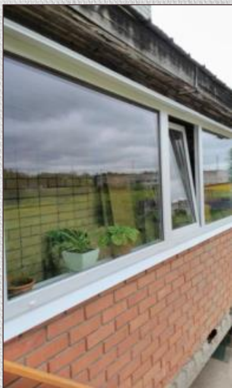
Заменены оконные блоки на энергосберегающие
