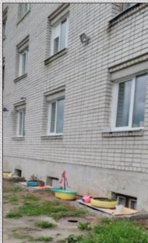
Заменены оконные блоки на энергосберегающие
