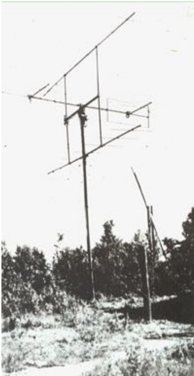
Антенная система станции дальнего радиобнаружения П-3 (принята на вооружение в 1945 г.).
