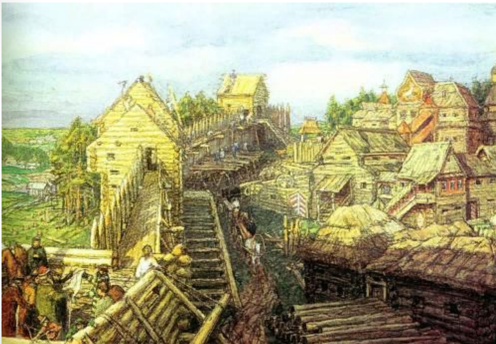
Деревянные стены первого Кремля
