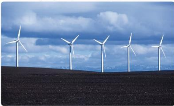
Вращение пропеллеров электростанции
