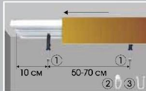
1. Разметить и просверлить отверстия в пластиковом профиле и потолке. Шаг отверстий от торца профиля - 10 см, далее 50-70 см в зависимости от размера карниза.
