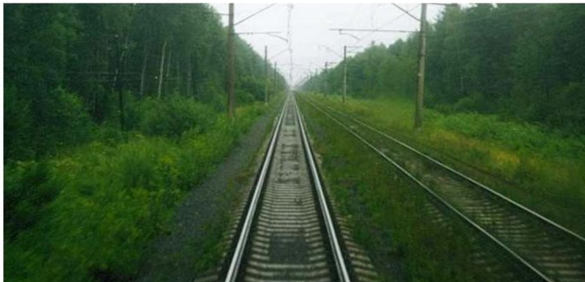
С учетом снегозаносимости железнодорожного пути создают 1-4-полосные и более снегозадерживающие насаждения, размещаемые в полосе отвода вдоль всех заносимых снегом участков пути.
