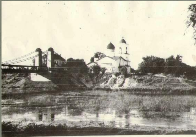
Рис 2. Место крепостного захаба и Никольская церковь. Вид с севера.
