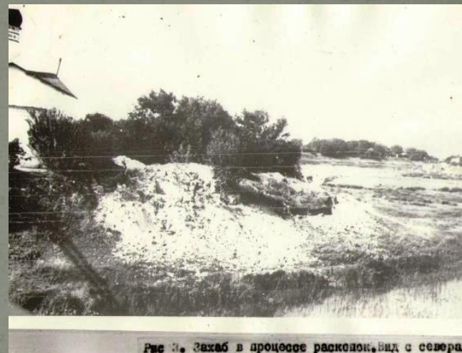
Рис 3. Захаб в процессе раскопок. Вид с севера.
