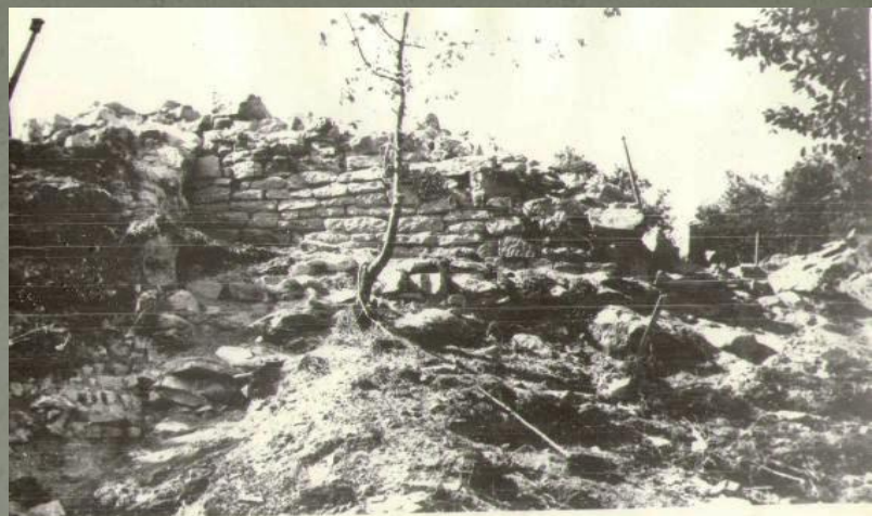
Рис 12. Северо-восточная стена башни середины XIV в. с прикладными. Вид с северо-востока.
