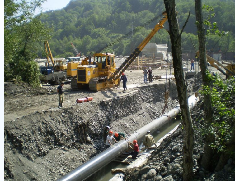
Строительство газопровода в горном кластере
