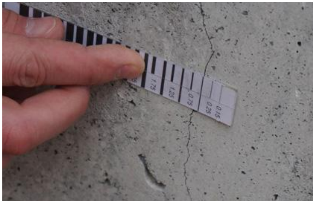
При помощи шаблона ширины раскрытия трещин
