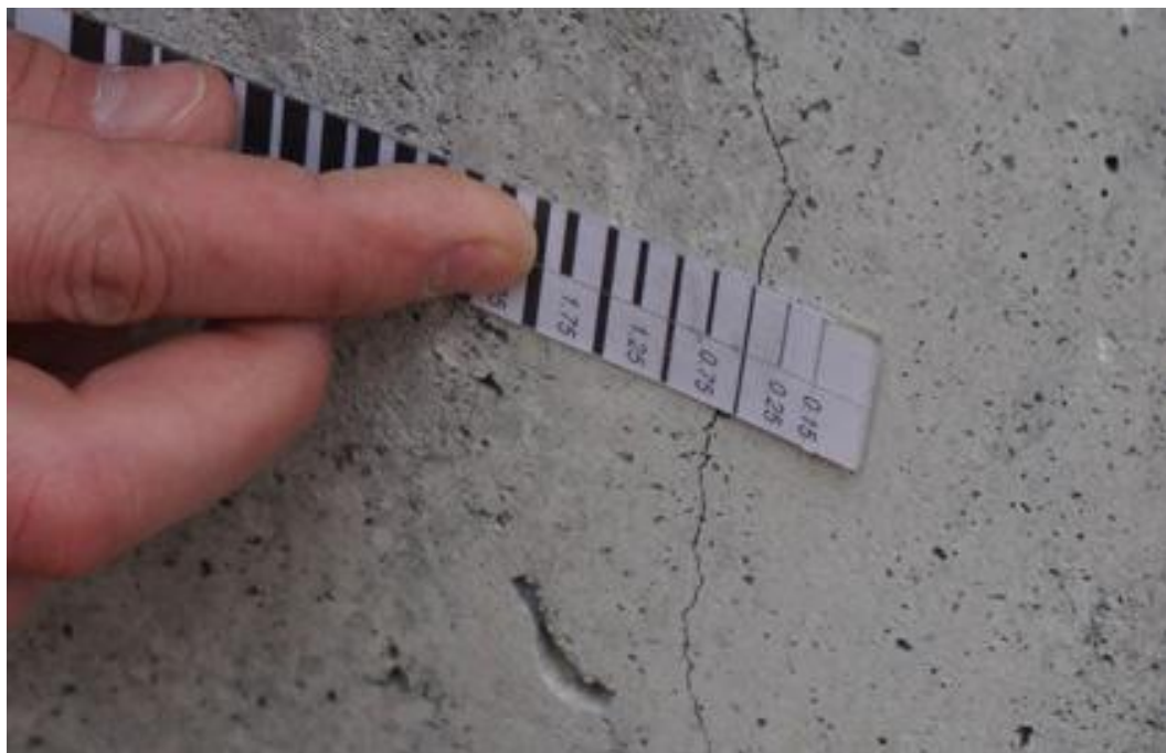
При помощи шаблона ширины раскрытия трещин
