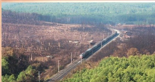
Движение на железнодорожном участке восстановлено
