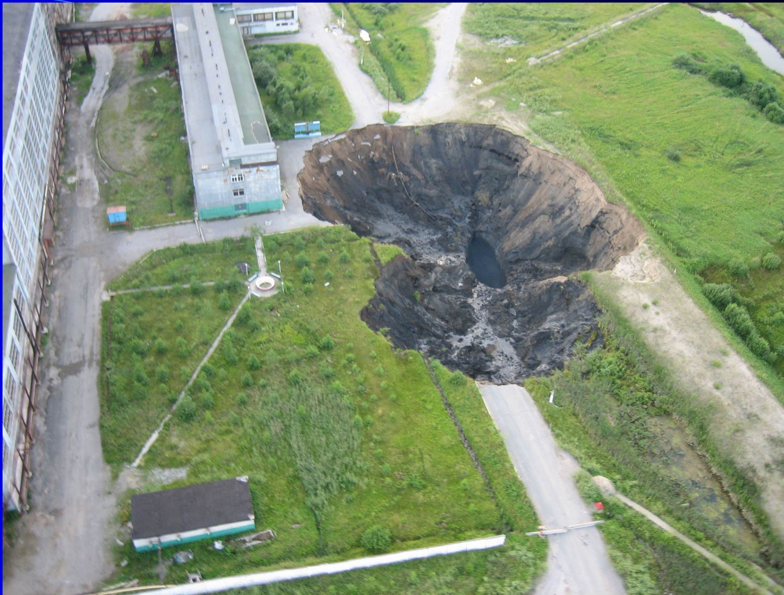
Рис. 7 Внешний вид провала земной поверхности на руднике 28 июля 2007 г
