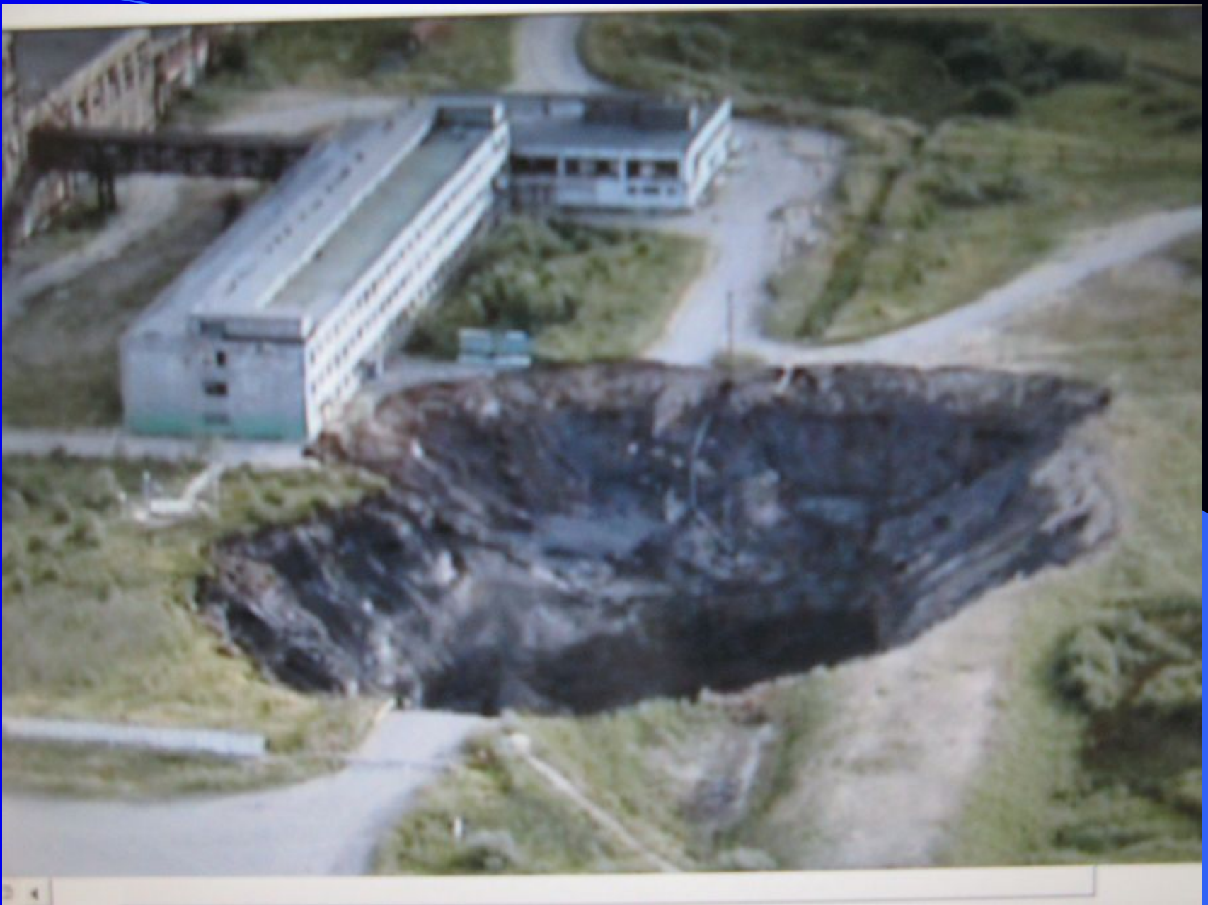
Рис. 13 Внешний вид провала по состоянию на 20 ч. 25 мин. 09.08.2007 г.
