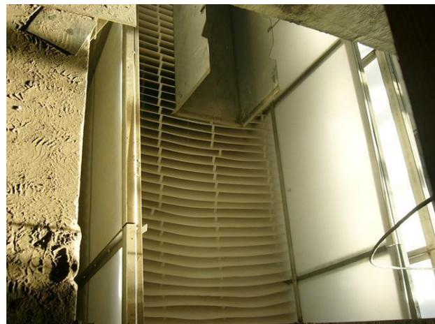
Горизонтальный отстойник с тонкослойными блоками
