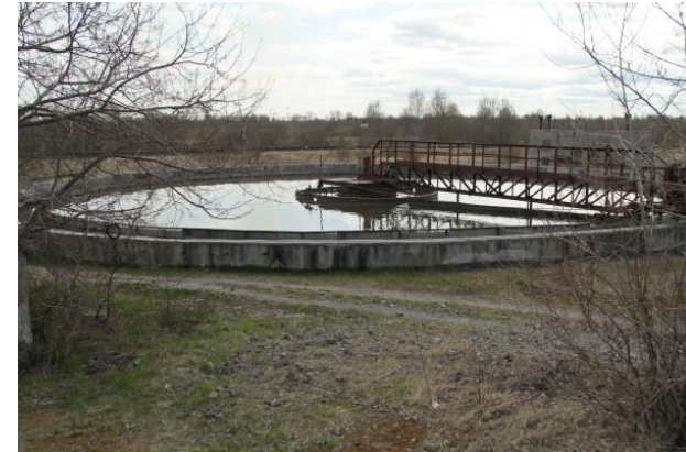
Радиальный первичный отстойник 1 – подача сточной воды; 2 – сборный лоток; 3 – отстойная зона; 4 – иловый приямок; 5 – скребковый механизм; 6 – удаление осадка
