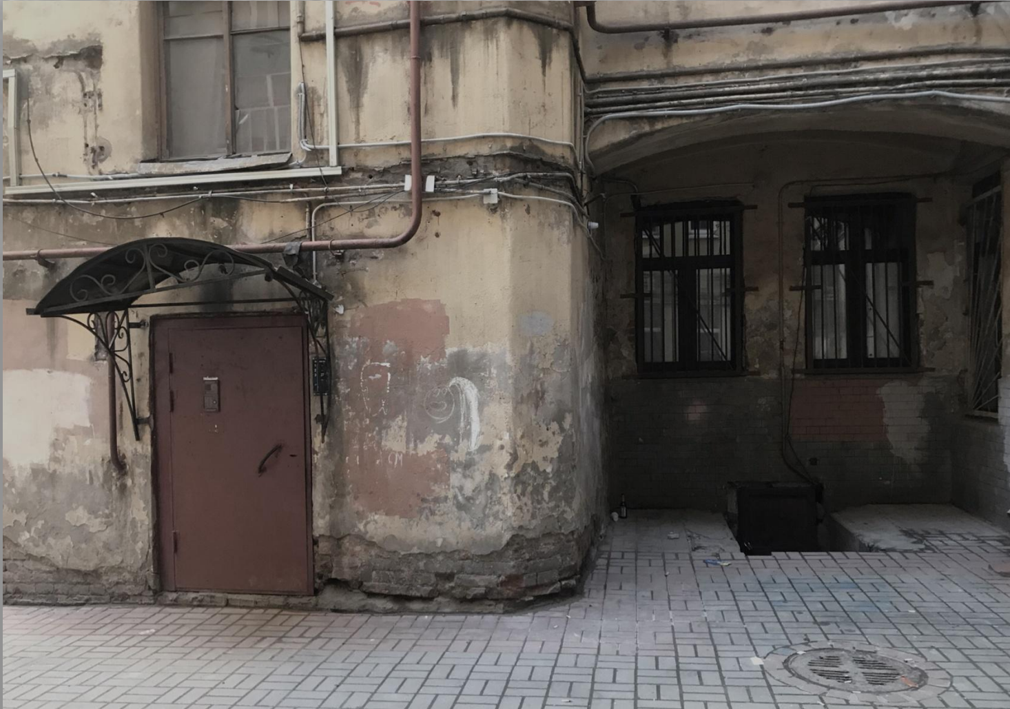
ВХОД В ПОДВАЛ
