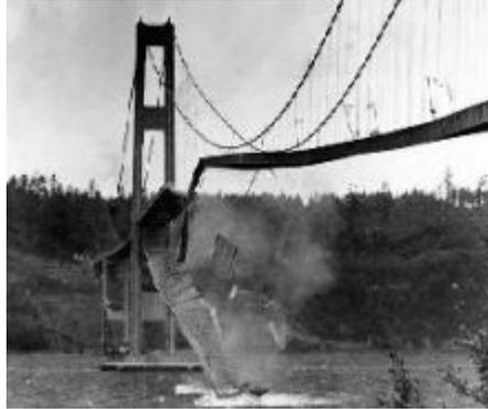
□ Явления резонанса могут приводить к серьезным разрушениям. Так в 1940г в США висячий мост Тэйкома обрушился из-за автоколебаний, вызванных ветром.
