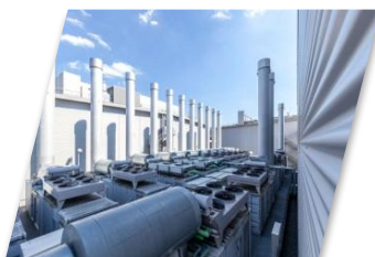
Центры обработки данных E-Shelter, Germany Evoswitch, Netherlands Google, California
