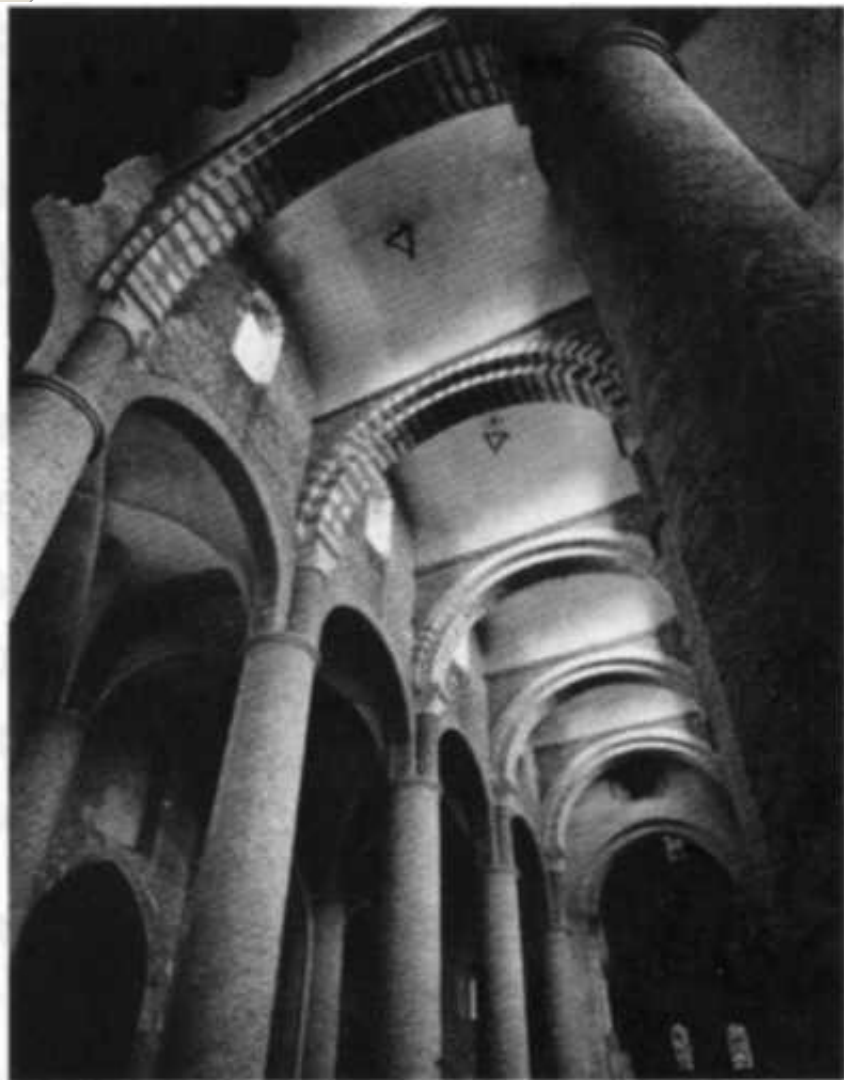
Бочарный свод на накладных арках с боковыми окнами
