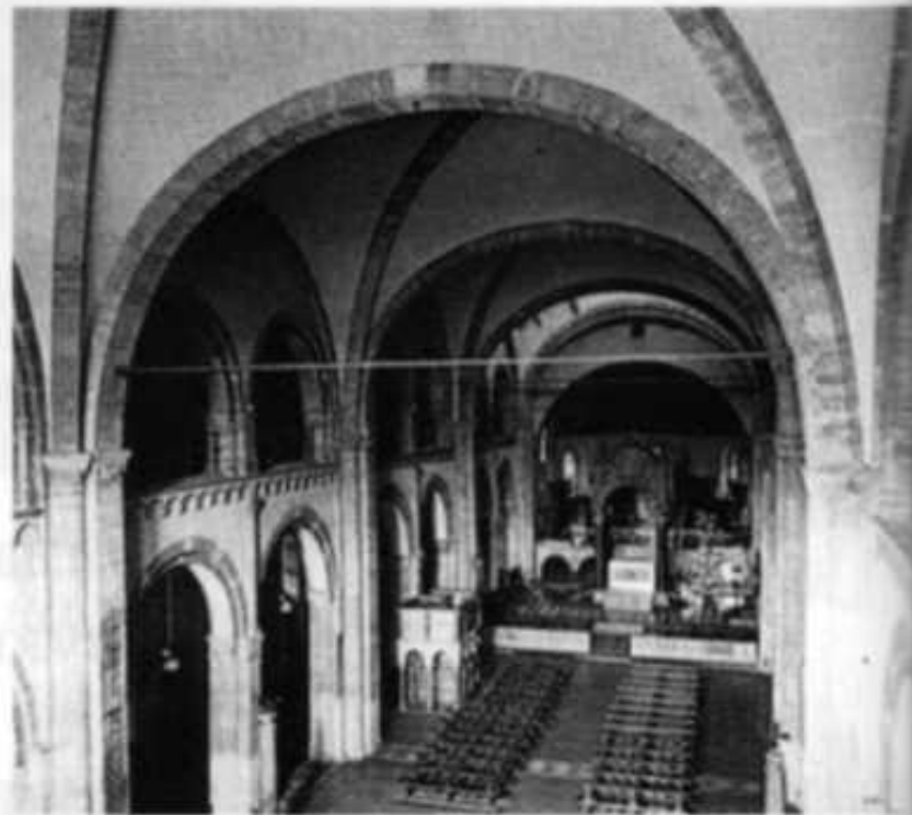
Базилика сопряженной конструкции с хорами. Сан-Амброджо, Милан (Италия)
