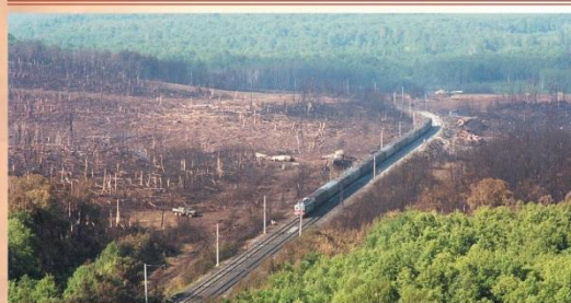
Движение на железнодорожном участке восстановлено
