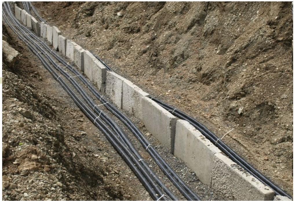
***Кабельной линией*** называется линия для передачи электроэнергии или отдельных ее импульсов, состоящая из одного или нескольких параллельных кабелей с соединительными, стопорными и концевыми муфтами (заделками) и крепежными деталями.
