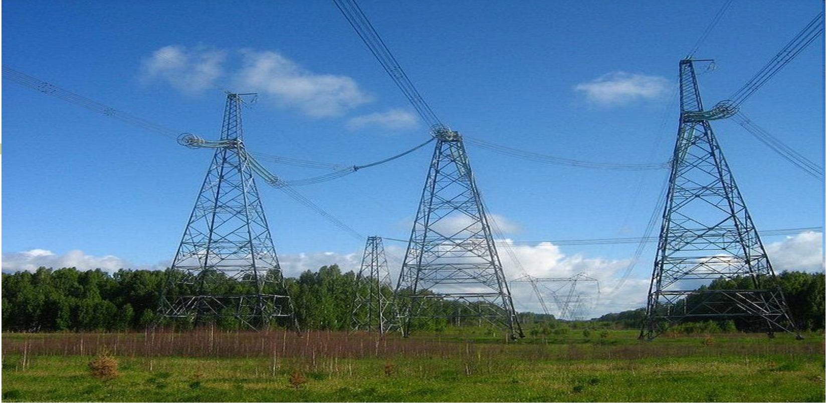
***Воздушной линией*** электропередачи называется устройство для передачи и распределения электроэнергии по проводам, расположенным на открытом воздухе и прикрепленным при помощи изоляторов и арматуры к опорам или кронштейнам, стойкам на зданиях и инженерных сооружениях (мостах, путепроводах и т.п.).
