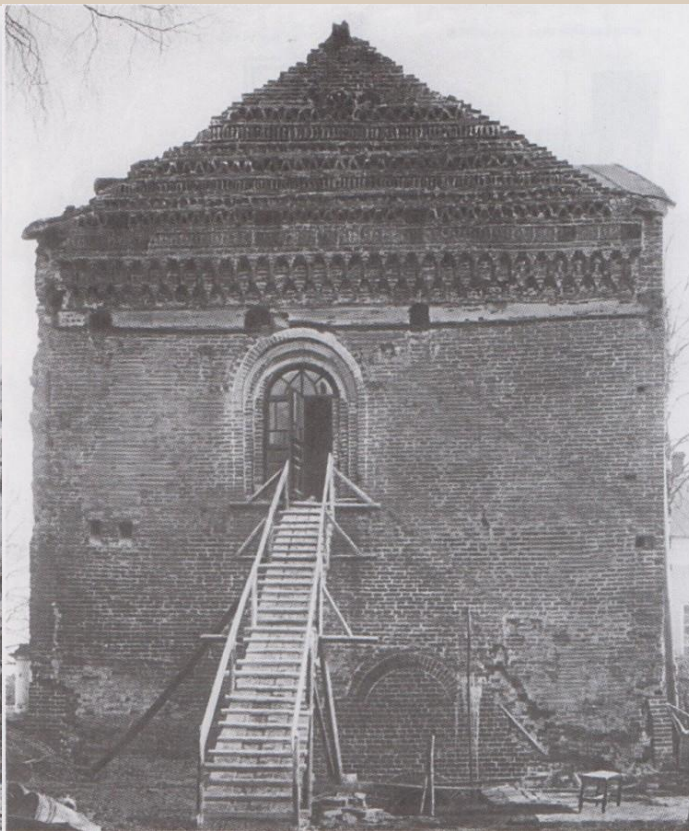
Северный фасад во время реставрации
