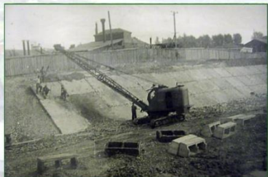
Строительство плотины. Июнь 1957 года
