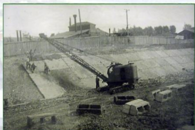
Строительство плотины. Июнь 1957 года
