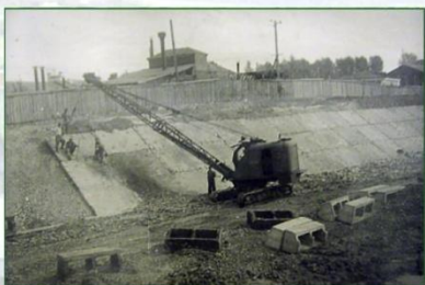
Строительство плотины. Июнь 1957 года
