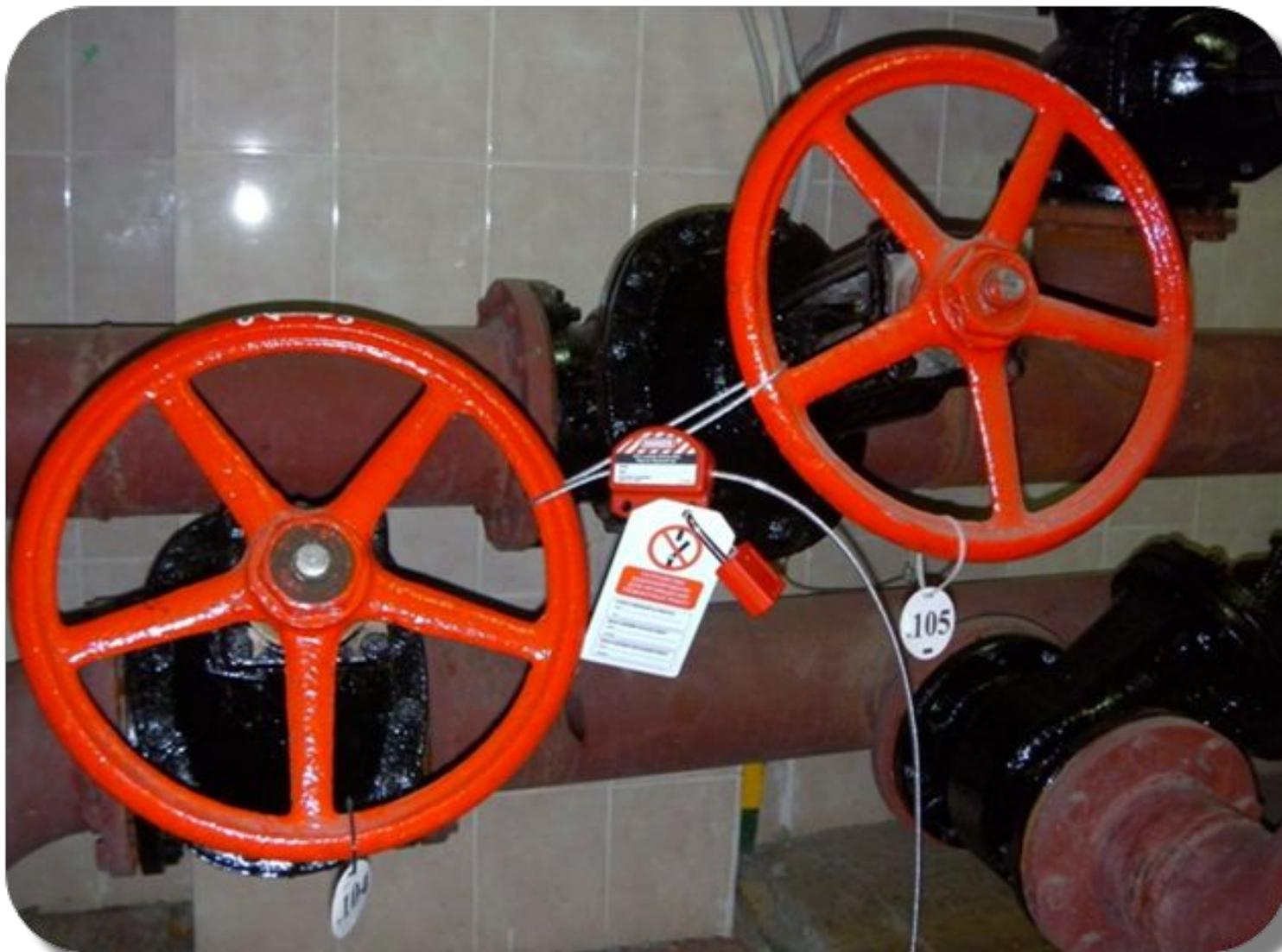
Универсальный блокиратор широкого диапазона применения. Идеально подходит для одновременной блокировки нескольких вентилях и выключателей. Широко применяется при блокировке нестандартных промышленных объектов: вентилях, дверей, щитков и т.п. Корпус из композита Zenex™; устойчив к химическим продуктам и экстремальным от  $-46^{\circ}\text{C}$  до  $+149^{\circ}\text{C}$ ).
