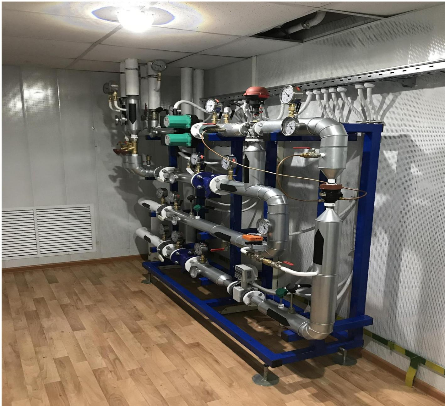
Фотография смонтированного ИТП на объекте
