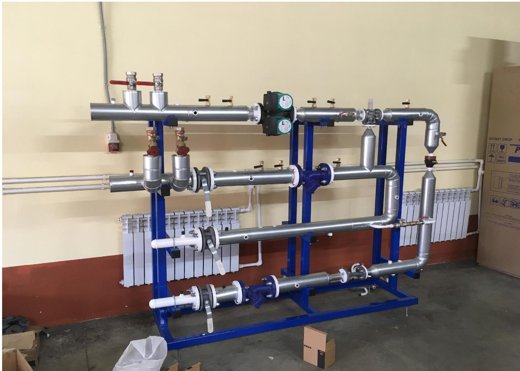
Фотография смонтированного ИТП на объекте
