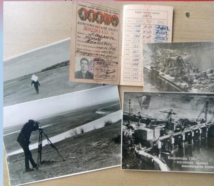
На строительстве Красноярской ГЭС
