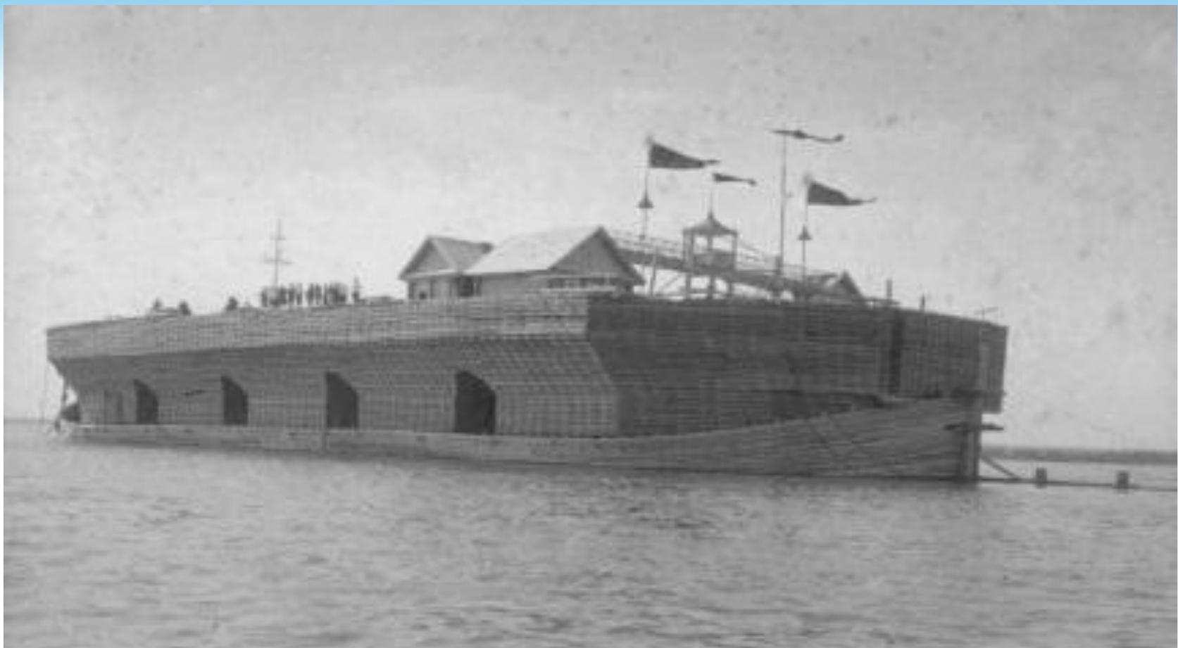
Беяны строились в местах добычи леса в Верхнем Поволжье и на Каме и были рассчитаны только на один рейс вниз по течению. Основным их грузом была древесина. В низовьях Волги, чаще всего в Царицыне, беяна полностью разбиралась на брёвна, которые использовались в качестве строительного материала или дров.
