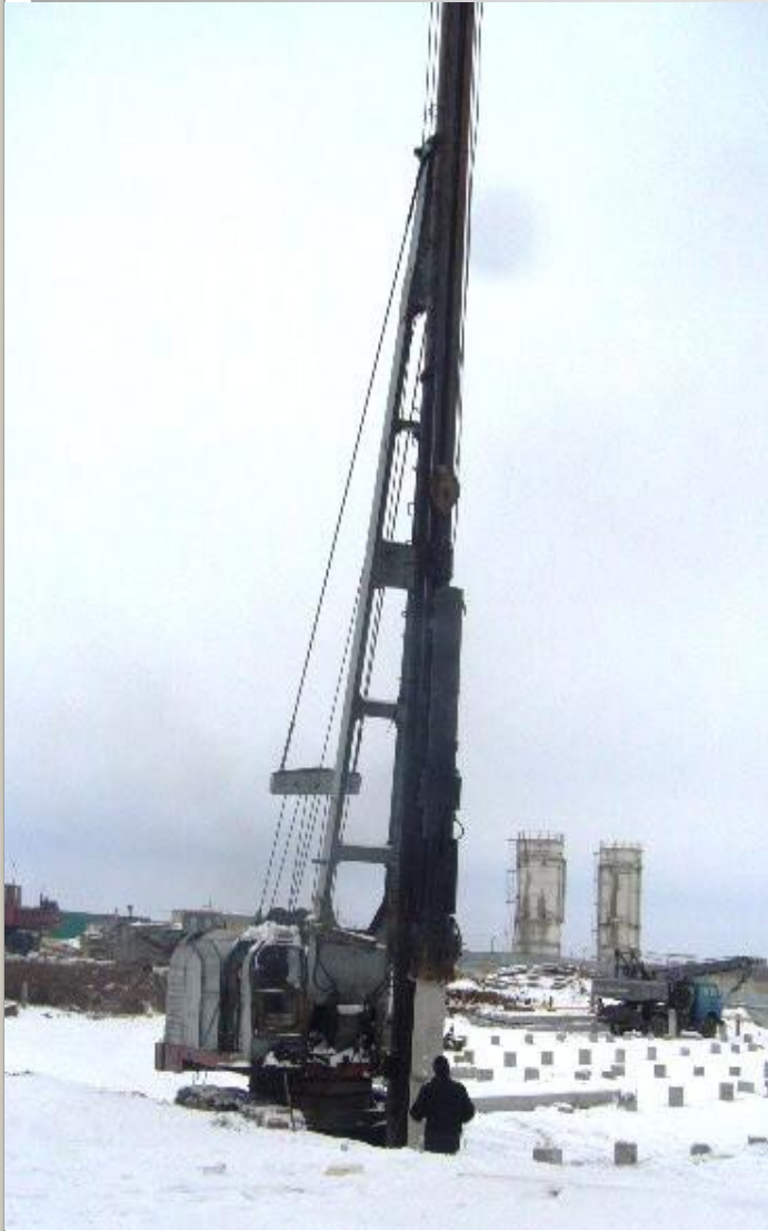
Забивание свай молотом копра
