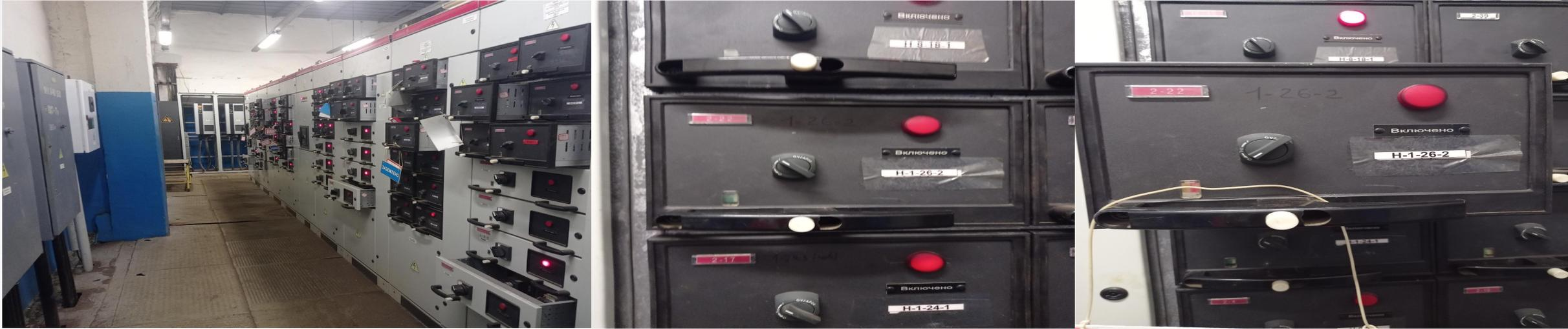
Автомат не выбит. Отключаем силоваой автомат выкатываем ячеку. Вывешиваем запрещающий плакат.
