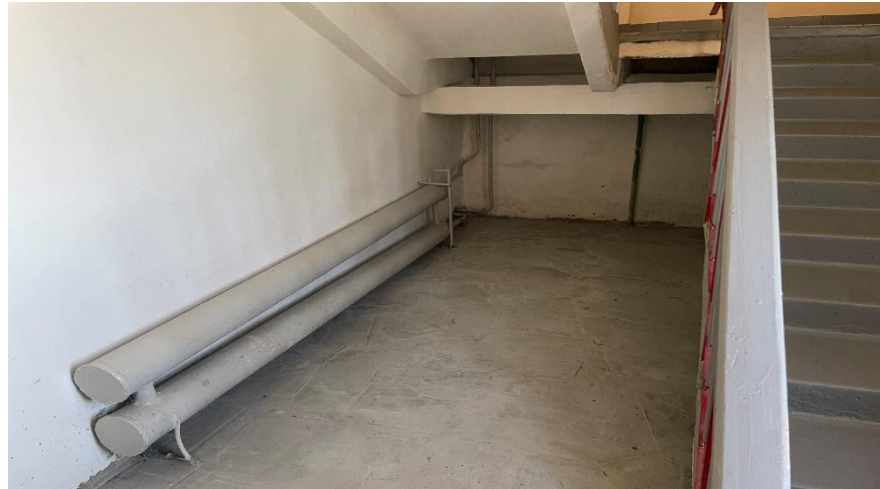
Состояние объекта после проведенных мероприятий (фото)
