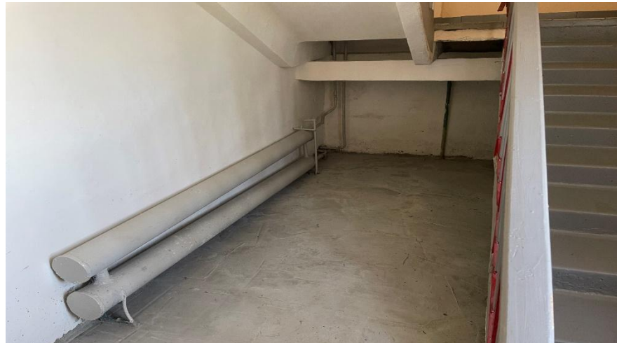
Состояние объекта после проведенных мероприятий (фото)
