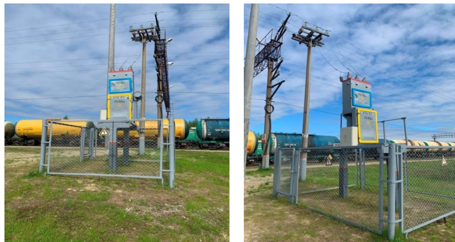
Состояние объекта после проведенных мероприятий (фото)
