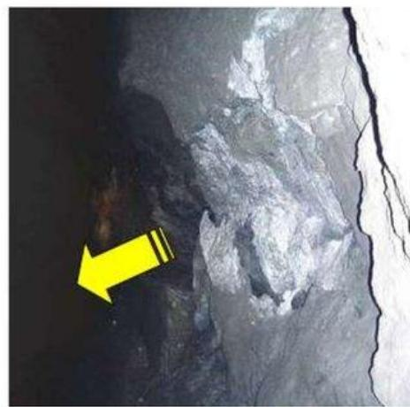
**Интенсивное заколообразование** – возникновение заколов вслед за их оборкой. Происходит по ненаруженному массиву и не связано с трещиноватостью, слоистостью и сланцеватостью. Сопровождается треском. Образующиеся и отделяющиеся при этом плиты повторяют по форме контур выработки;
