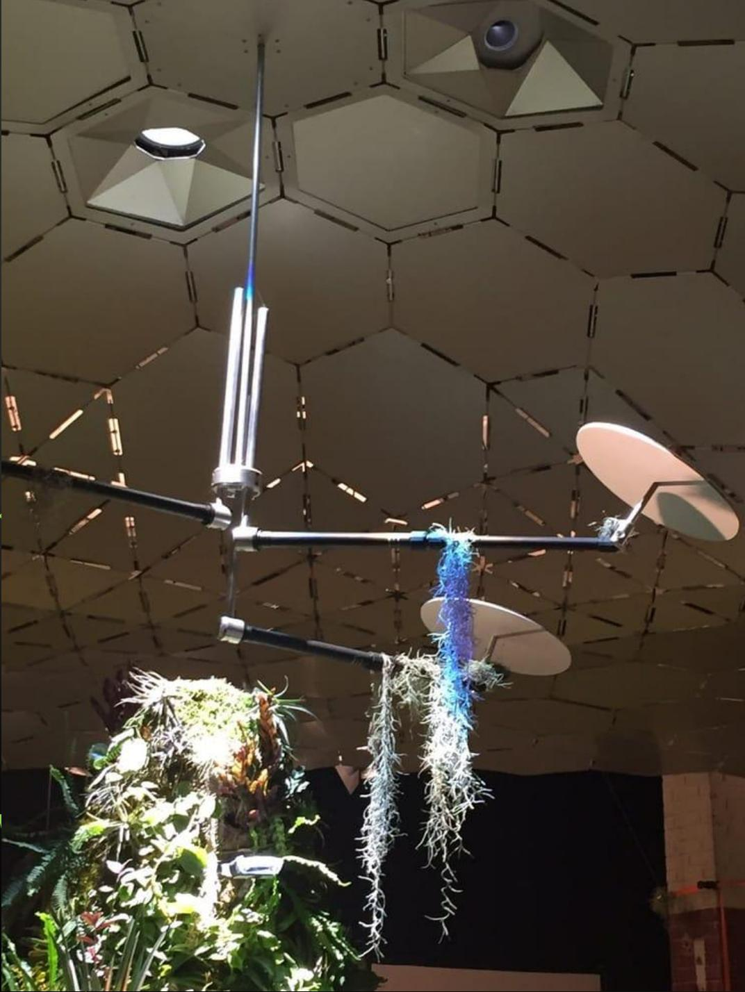
подземный парк будет освещаться с помощью системы из спрятанного за стеклом параболического уловителя, способного поворачиваться в зависимости от положения солнца в тот или иной день года, оптоволоконной «гелио-трубки», проводящей свет через находящуюся над терминалом станцию метро к зеркальной «тарелке», которая и распределяет свет по парку
