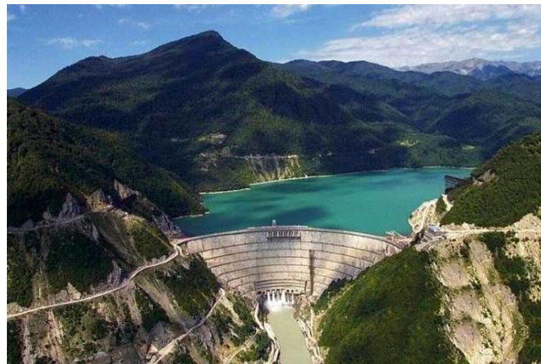
Ингульская ГЭС, Ингури, Грузия, 1,3 ГВт
